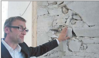
Architekt Lukas Gäbele schwört auf die guten Klimateigenschaften der dicken Bruchsteinmauern.
