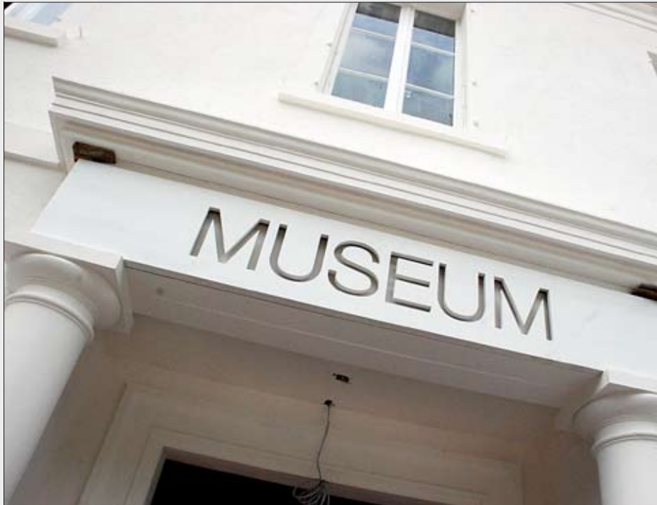
Die gelbe Fassade ist Vergangenheit, jetzt erstrahlt das ehemalige Museums kino in reinem Weiß.
